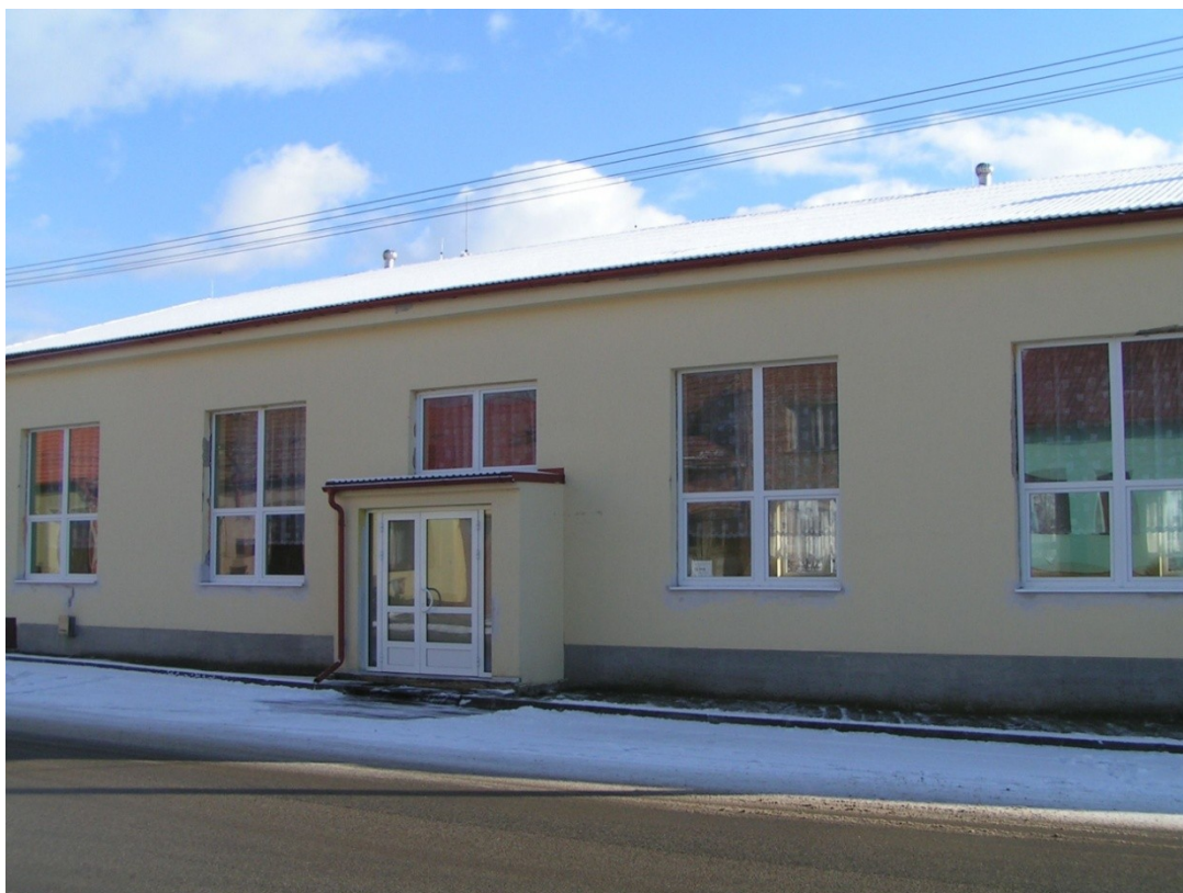
Příloha č. 12: KD z roku 1966 ve Starém Poddvorově. Rekonstrukce 2009.
