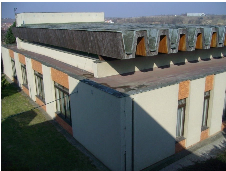
Příloha č. 4: Střešní konstrukce KD v Čejkovicích.
