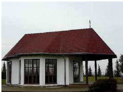
Fotografie 39- Kaple Všech svatých. Zdroj: vlastní zpracování.(CC)BY-NC
